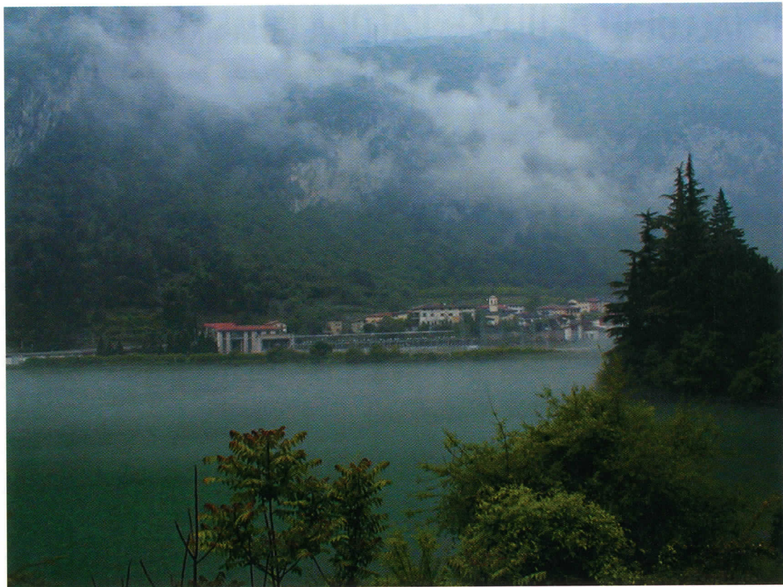
Un'insolita immagine della centrale idroelettrica di Santa Massenza.
